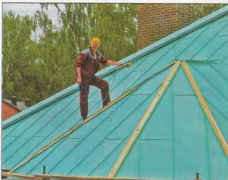
Один из моих первых учеников — сын Ярослав. Монтаж объёмных коньков кровли эркера. Материал — патинированная медь КМЕ.
