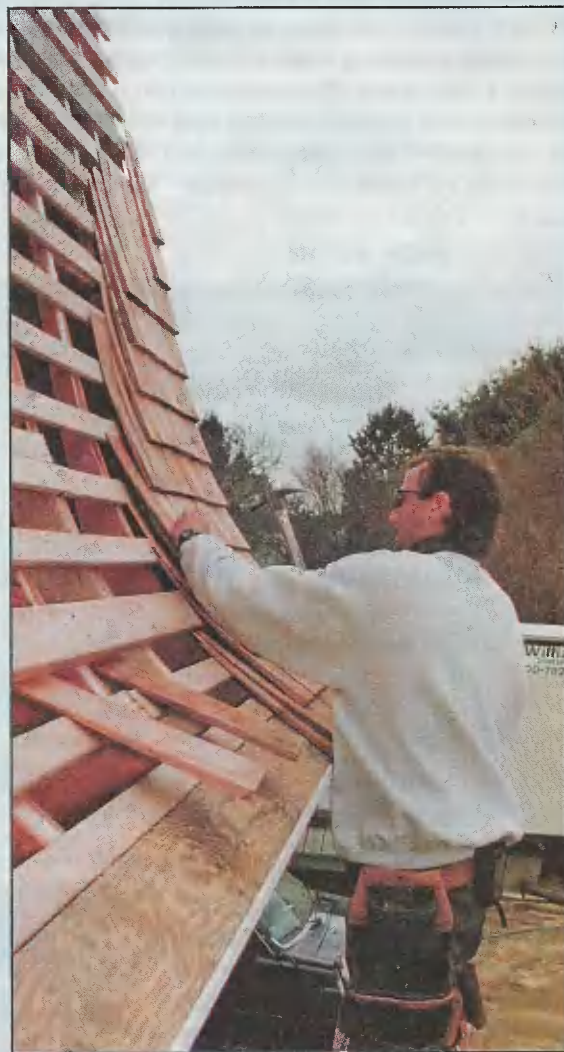
Обрешётка на изогнутых элементах — основание для крепления гонта.
