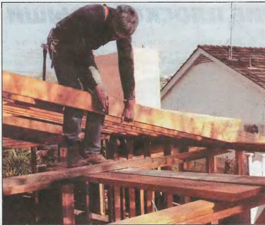
Монтаж «датских» стропил. Их установка ничем не отличается от монтажа стропил любого навеса с односкатной крышей.
