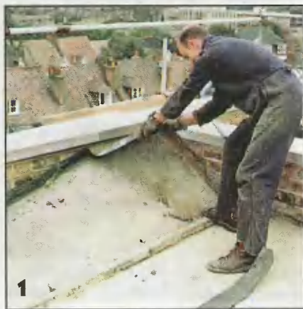
1 Старую кровлю полностью удаляют. Гвозди вытаскивают гвоздодёром.
