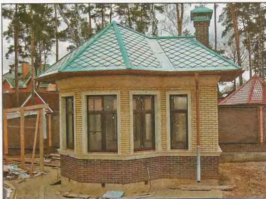
Беседка. Кровля выполнена объёмными ромбами из патинованной меди КМЕ. На таких объектах реально закрепляются навыки, полученные при обучении на макетах.
