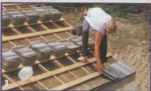
Де Джонг начинает укладку первого ряда черепицы, надевая её на первую планку.
