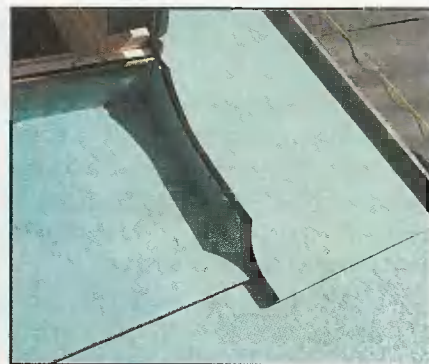
Подгонка элементов обводки мансардного окна без окладов.
