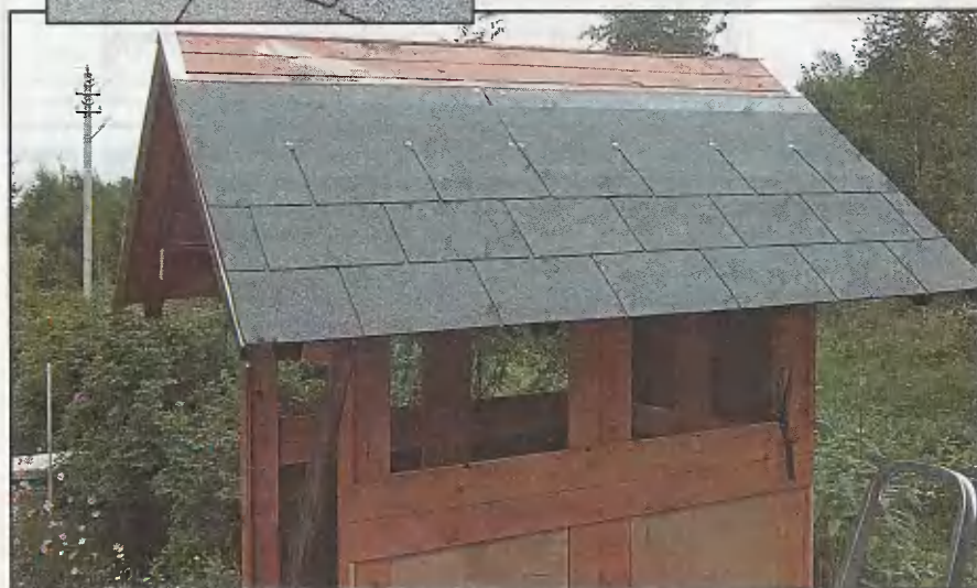
Кровельные пластины уложены со смещением в рядах на половину ширины одного гонта. Для крепления пластин к настилу использованы гвозди и нарезанные из оцинкованного железа шайбы. Крепление каждой пластины — три гвоздя сверху и по одному — над каждым вырезом.
