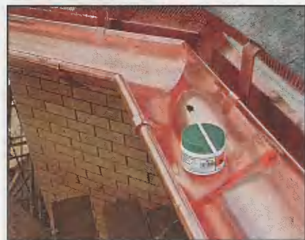
Внутренний нестандартный угол водосточного жёлоба, подготовленный к пропайке шва.
