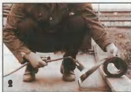
Стыки между фанерными плитами закрывают полосами битуминизированного материала, навариваемого при помощи газовой горелки.
