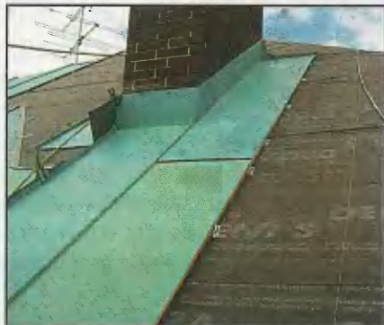
Подгонка деталей воротника каминной трубы.
