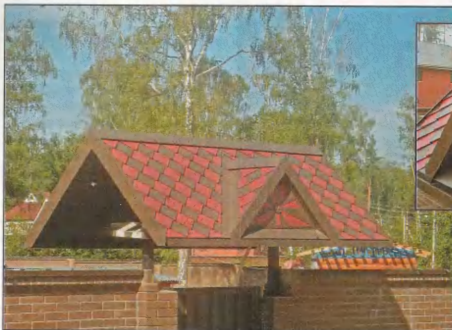
Выпускная работа учеников школы «Саврос» — навес из двухцветного алюминия ПРЕФА над входной калиткой усадьбы в Мещерино, Подмоскowie.
