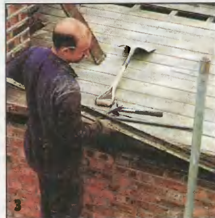
3 Карниз подвергается интенсивным атмосферным воздействиям. Поэтому его следует внимательно осмотреть.
