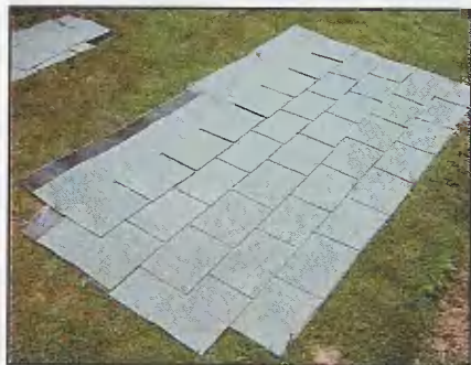
Для маленького ската проверку кровельного ковра целесообразно сначала сделать на земле.
