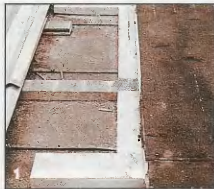
Укладка основания из фанерных плит.
