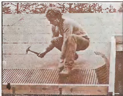
Укладка первой полосы фундалина. Между защитным слоем и нижней гранью ограждающей доски — зазор не менее 2 см.
