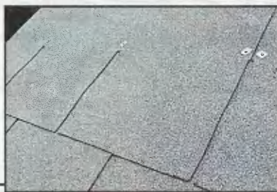
Кровельные пластины уложены со смещением в рядах на половину ширины одного гонта. Для крепления пластин к настилу использованы гвозди и нарезанные из оцинкованного железа шайбы. Крепление каждой пластины — три гвоздя сверху и по одному — над каждым вырезом.
