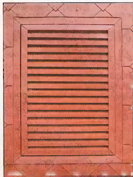
Дверь фронтона жалюзийного типа из алюминия ПРЕФА, которую изготовил Женя.
