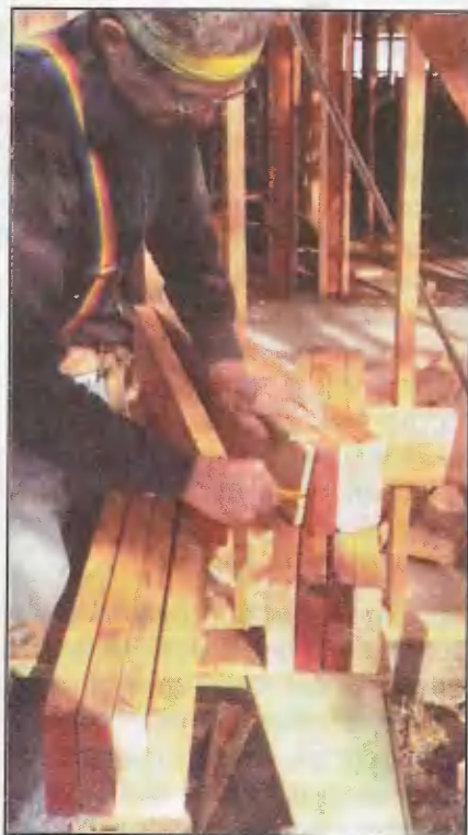
Быстрая разметка стропил по шаблонам. На фото слева для разметки профиля врубки автор применяет шаблон свеса. Сечение вальмового стропила больше других, что учитывают при формировании нижней его части. На фото справа автор также использует шаблон для разметки запила на других стропилах.
