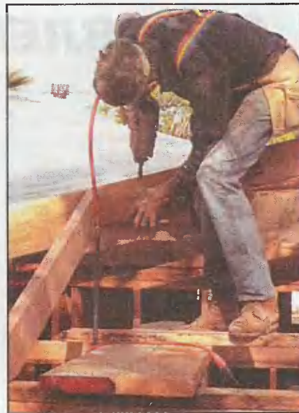
Проставки предотвращают скручивание стропил. Такие распорки установлены между всеми стропилами.
