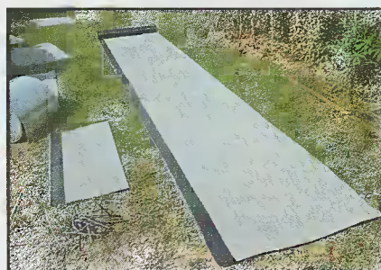
Работать с рулонными кровельными материалами на основе битума не следует ни в сильный солнцепёк (материал «плывёт»), ни при низких температурах воздуха.
