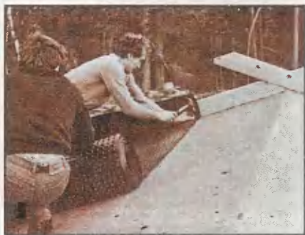
У ветровых досок фундалин закрепляют по краям, напуская его на ограждение.
