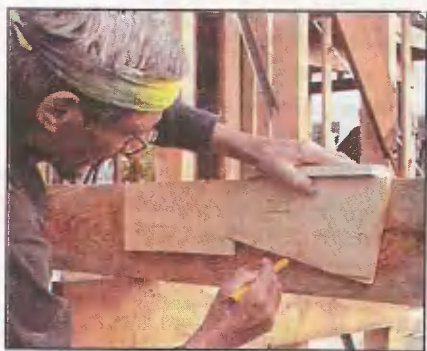
Быстрая разметка стропил по шаблонам. На фото слева для разметки профиля врубки автор применяет шаблон свеса. Сечение вальмового стропила больше других, что учитывают при формировании нижней его части. На фото справа автор также использует шаблон для разметки запила на других стропилах.
