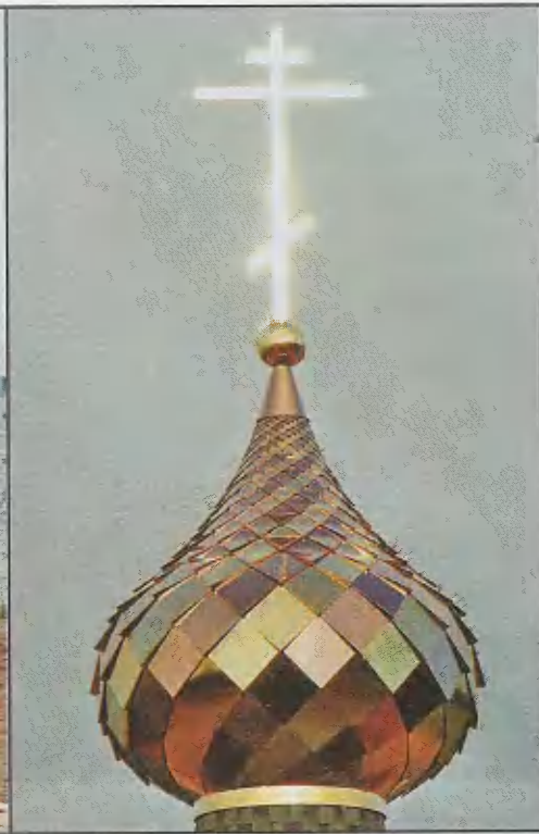
Кровлю из нержавеющей стали с нитрид-титановым покрытием крыльца и купола деревянного храма выполнили мастер и два ученика школы «Саврос». Осташковский район, Тверской области, с. Петриково.
