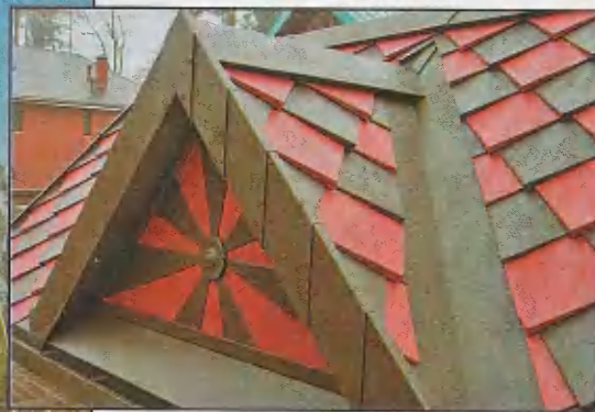
Выпускная работа учеников школы «Саврос» — навес из двухцветного алюминия ПРЕФА над входной калиткой усадьбы в Мещерино, Подмоскowie.
