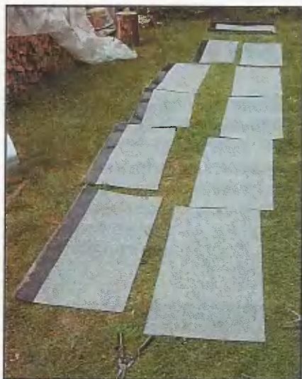
Для скатов с размерами 1,2х2,0 м рулон был распущен пополам по ширине, а затем на отдельные фрагменты длиной 1 м.
