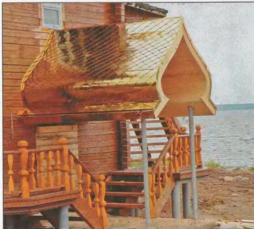
Кровлю из нержавеющей стали с нитрид-титановым покрытием крыльца и купола деревянного храма выполнили мастер и два ученика школы «Саврос». Осташковский район, Тверской области, с. Петриково.
