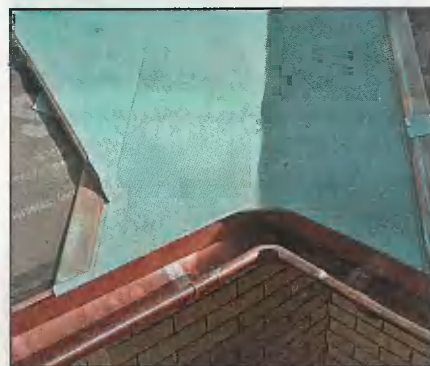
Узел сопряжения ендовы и фартука водосточного жёлоба.
