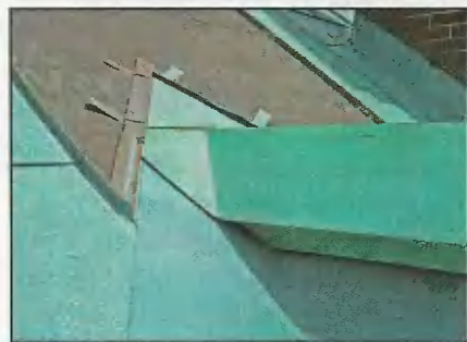
Узел врезки объёмного вентилируемого конька в основную кровлю выполнен по технологии, разработанной специалистами компании «Саврос».
