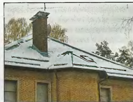
Зимой два ряда снегозадержателей предотвращают резкий сход подтаявшего снега и более равномерно распределяют нагрузку на фальцы, к которым крепятся кронштейны снегозадержателей.
