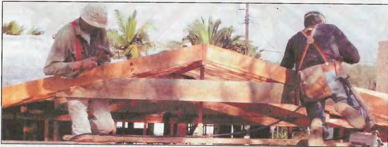
Разметка положения опорной доски. После разметки положения верхней плоскости опорной доски её сбивают с двумя «датскими» стропилами и поднимают всю сборку наверх к линии разметки.
